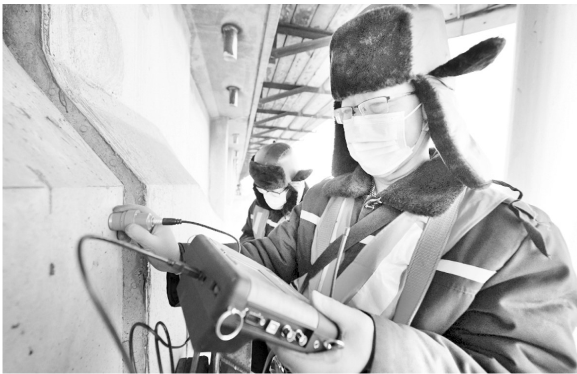
4月5日,太原铁路局工务段技术人员正手持无线数传桥梁振动检测仪监测桥梁状态,为桥梁“健康”把脉。铁路桥梁在服务人们交通出行的同时,也需要定期体检,相较于过去眼看、手敲、尺量的检查手段,现在使用的都是科技含量满满的精密仪器。“无线数传桥梁振动检测仪”是将3个探头均匀布置在桥梁的桥墩或梁跨处,收集列车运行时桥梁振动数据,方便检修人员更加精准、高效地掌握桥梁设备状态,为桥梁维护保养提供科学依据。科学导报记者 刘挪娜
