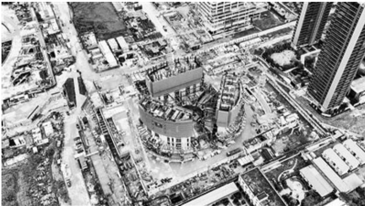
图为新一代“空中造楼机”。受访单位供图
