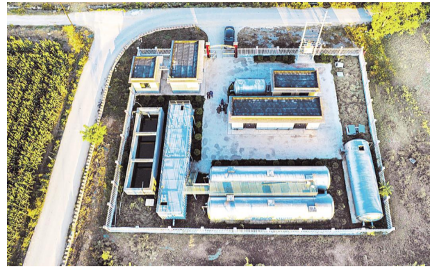
襄汾县近年来先后建成6座乡村污水处理厂，加大农村污水处理力度，从而使农村道路畅通、空气清新，生态环境持续改善。图为10月17日拍摄的襄汾县南贾镇东张村的南贾污水处理厂全景。 ■王稳锁 摄
