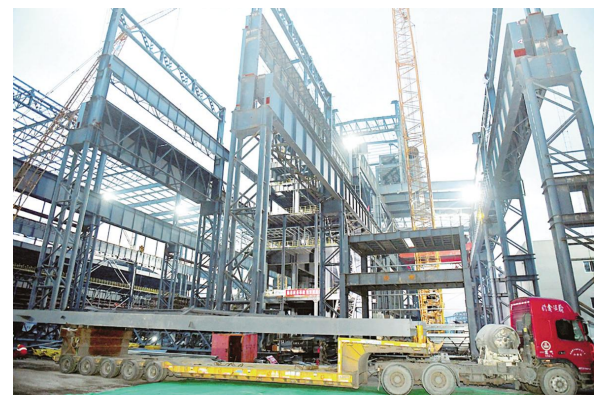
11月8日，稷山县铭福钢铁制品有限公司投资28.2亿元的产能减量置换升级改造项目正在加紧施工。目前烧结、制氧、高炉配套喷煤项目及配套设施已建成投产，高炉和转炉项目预计2023年年底竣工。项目建成后，工艺运行标准达到国内同行业先进水平，大幅降低能源消耗，推动企业实现绿色低碳发展。■栗卢建 摄
