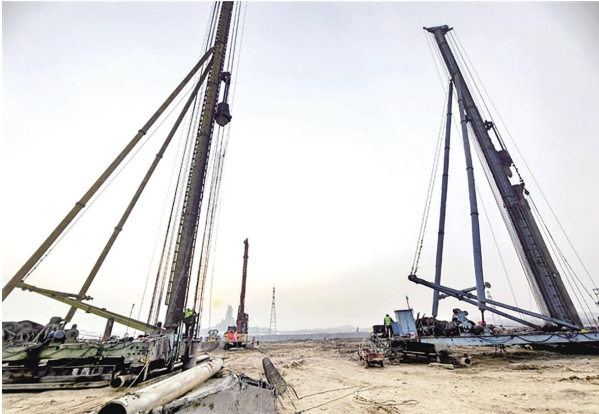
太行世纪（阳泉）年产10GWh动力储能两用高端固态锂（钠）离子电池生产线项目现场，工人正在进行桩基施工。 ■ 吴珊珊
