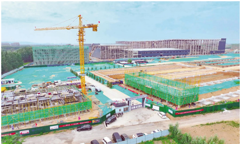
科学导报 近日，长治高新区智能高端装备制造产业三期项目建设现场呈现一派繁忙
