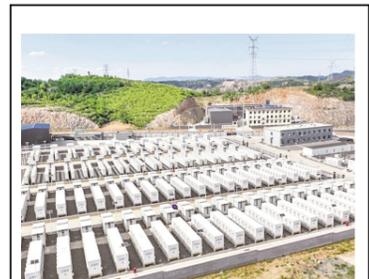
阳泉高新区储能项目位于唐碾园区，该项目旨在解决电网调峰能力不足问题的同时，提升电网运行灵活性，可满足阳泉市光伏发电消纳及送出需要，促进经济发展，优化阳泉市能源结构。该项目规模200MW/400MWh，5月1日开始并网交易，当月实现工业产值约500万元。 张哲远摄
