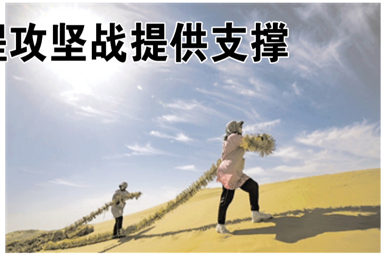
治沙工人在宁夏中卫市境内的腾格里沙漠铺设刷状网绳式草方格沙障。冯开华摄
